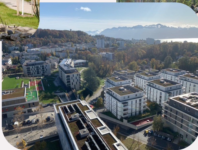
SCHL | Lausanne/Le Mont-sur-Lausanne 405 logements
